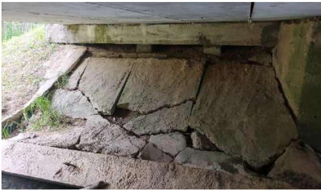
8 pav. Tilto patiltės tvirtinimo būklė. Tvirtinimas pasislinkęs, sulūžęs, atraminis elementas įkritęs į upės vagą, iš po krantinių atramų byra gruntas.
