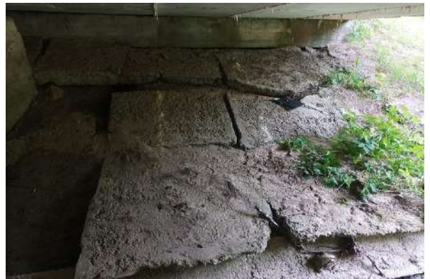
8 pav. Tilto patiltės tvirtinimo būklė. Tvirtinimas pasislinkęs, sulūžęs, atraminis elementas įkritęs į upės vagą, iš po krantinių atramų byra gruntas.
